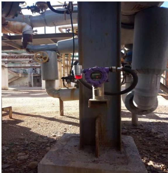
图 4-13 航锦科技 罐区自动监控报警系统
