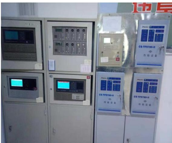
图 4-11 航锦科技 罐区有毒有害物质自动监控报警系统
