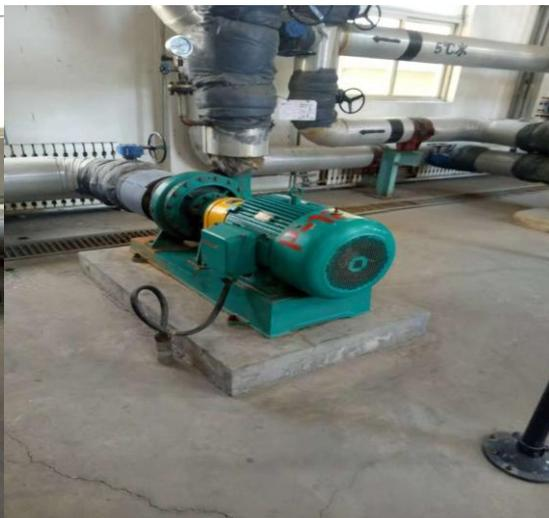
图 4-4 航锦科技 低噪声的设备机泵与消音泵房
