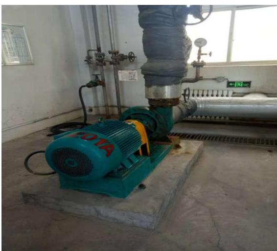
图 4-3 低噪声的设备机泵与消音泵房
