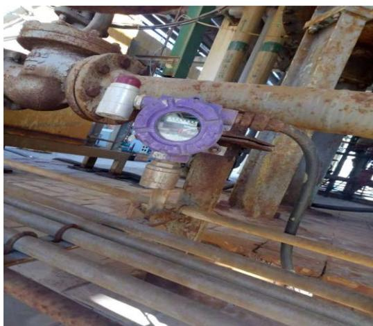
图 4-12 航锦科技 罐区自动监控报警系统
